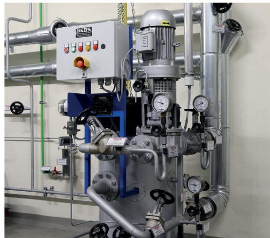
Eingebaute Feinfilterstation FF300
