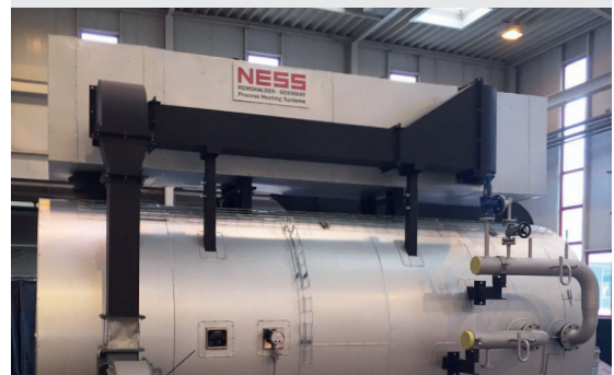
Erhitzer mit montiertem Verbrennungsluftvorwärmer
