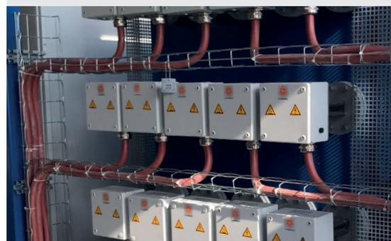
Нагревательные фланцы электрических термомасляных установок мощностью 50 кВт каждый
