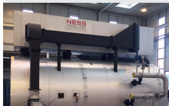
Нагреватель с установленным подогревателем воздуха для горения
