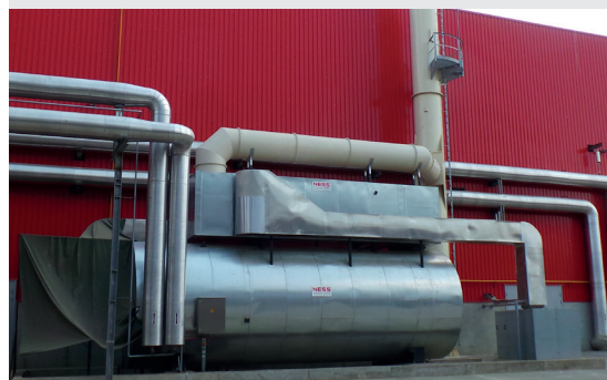
Интегрированный нагреватель на газовом топливе (серии WEH) с воздухоподогревателем (Luvo)
