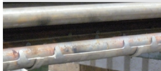
NESS Schutzschalen werden auf den zu schützenden Rohren entsprechend befestigt
