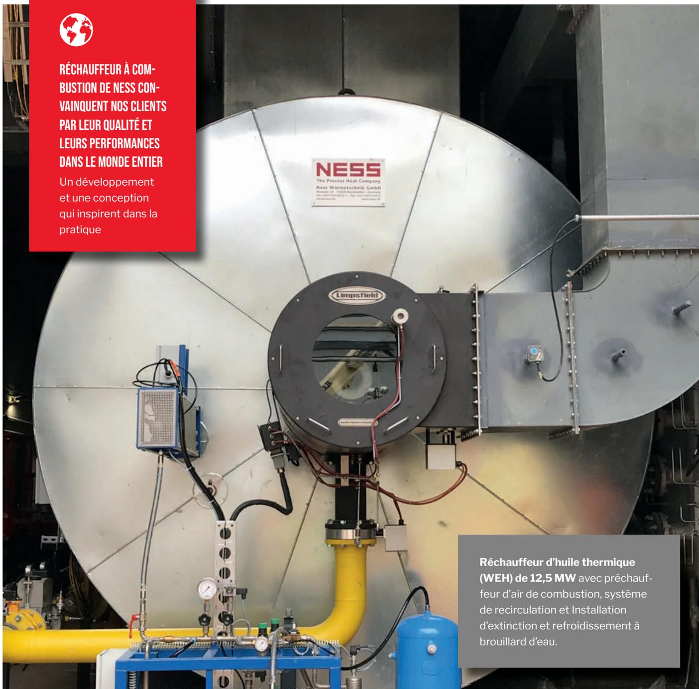
**Réchauffeur d'huile thermique (WEH) de 12,5 MW** avec préchauffeur d'air de combustion, système de recirculation et installation d'extinction et refroidissement à brouillard d'eau.
