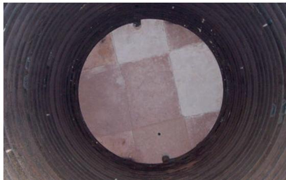
**Paroi arrière de l'appareil de chauffage en béton réfractaire léger**
