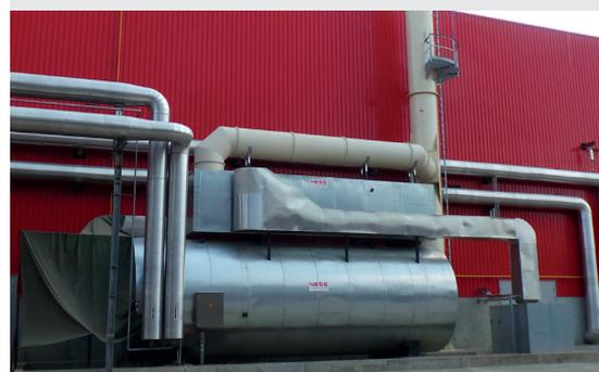
Réchauffeur intégré à gaz (conception WEH) avec préchauffeur d'air de combustion (Luvo)
